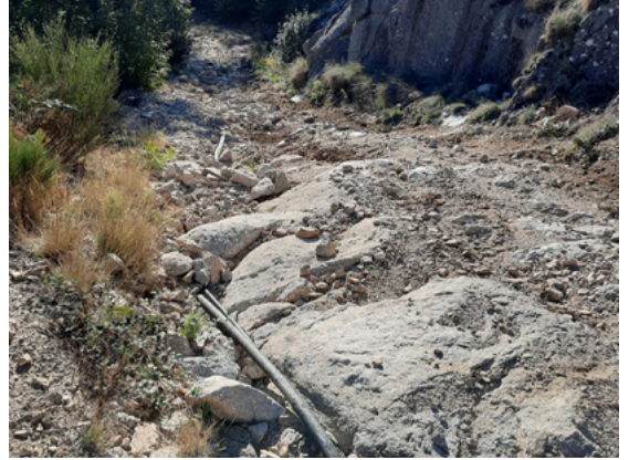
Photo 6 - Piste de DFCI dégradée
